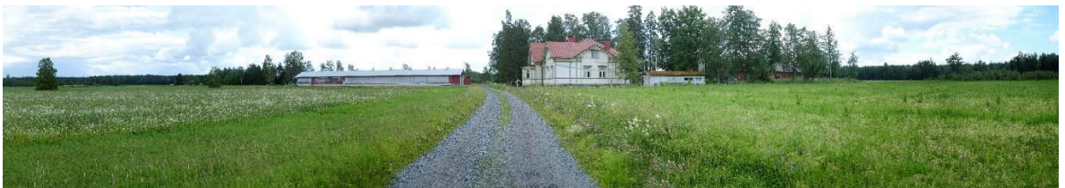
Kuva 4.9 Näkymä Pelto-Laurilalle pohjoisesta. Huvilamainen päärakennus näkyy kuvassa selvästi.
