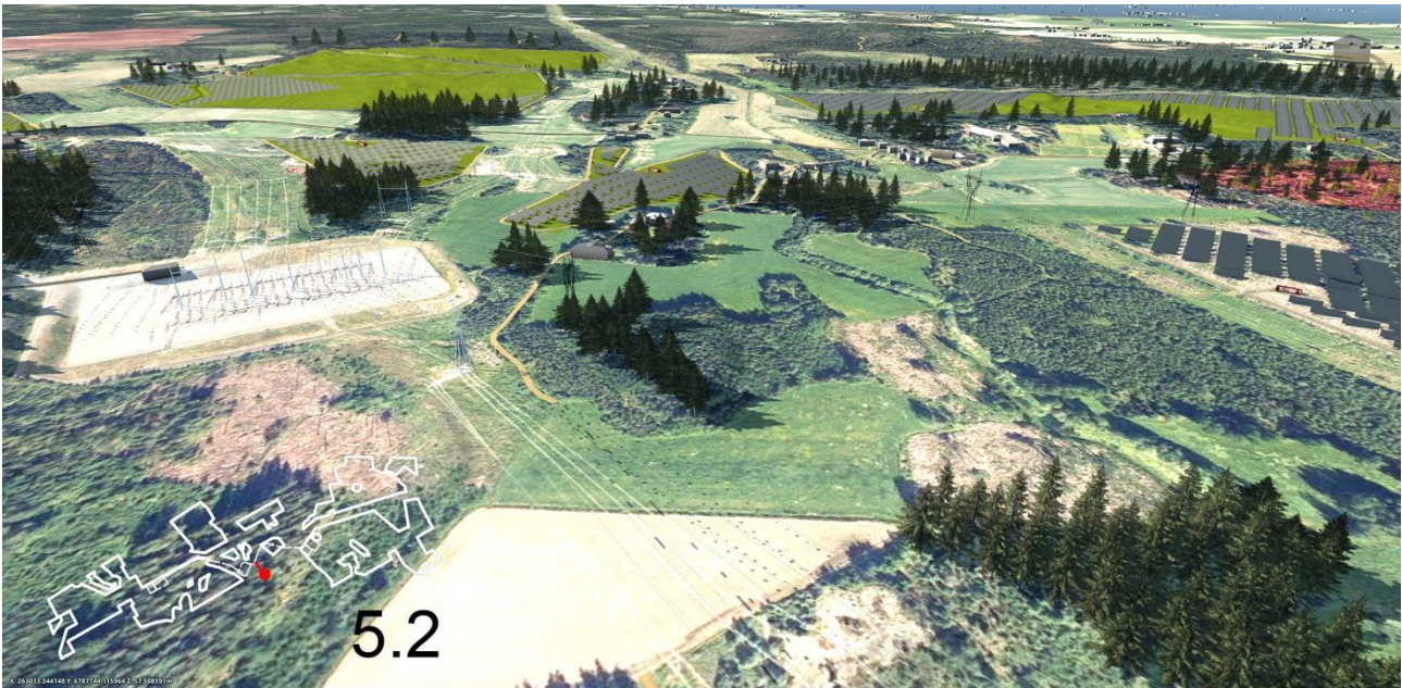
Kuva 41: Yläviistonäkymä Huittisten sähköaseman ympäristöstä.
