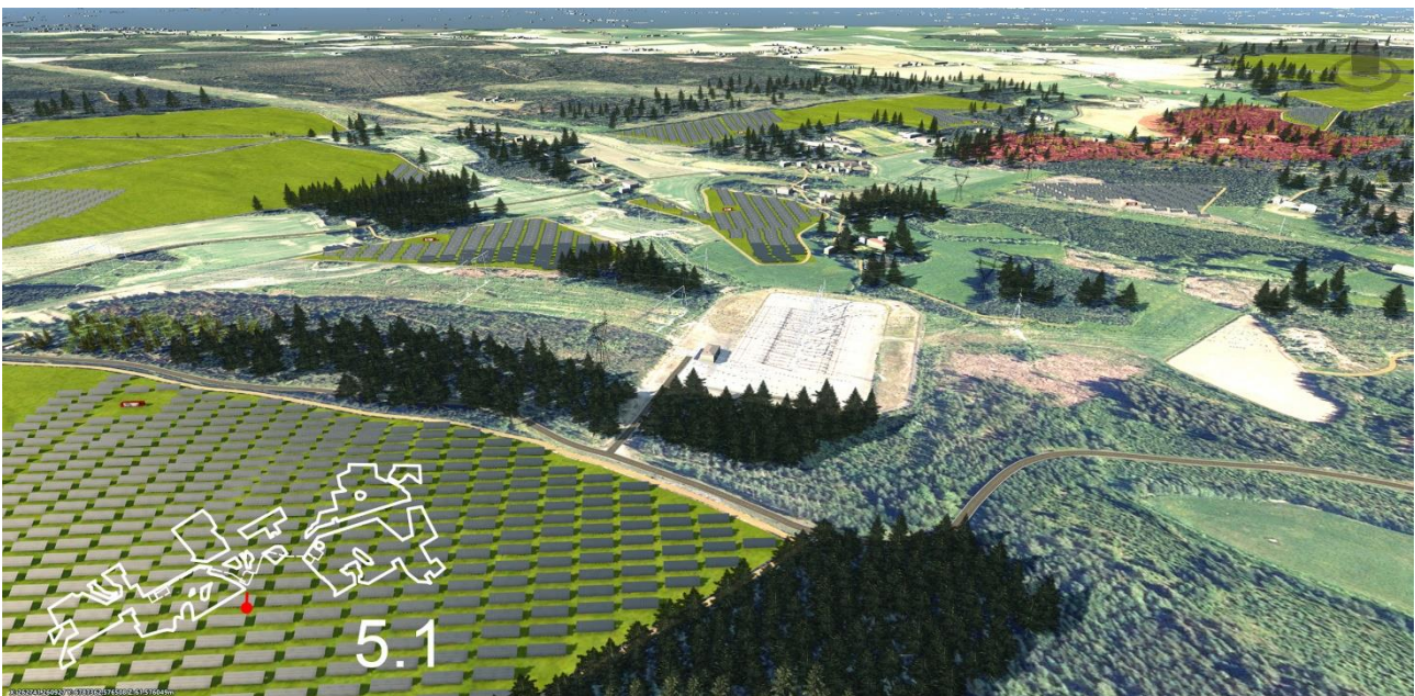
Kuva 40: Yläviistonäkymä Huittisten sähköaseman ympäristöstä.
