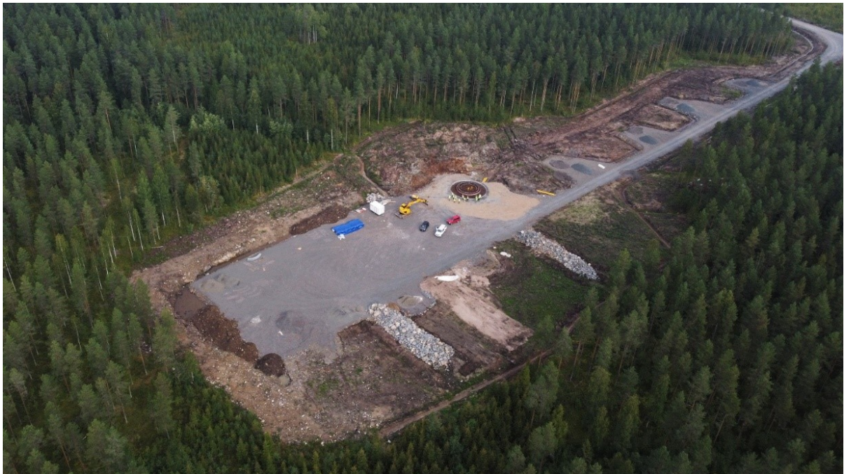
Kuva 30. Tuulivoimalan kokoamis- ja työskentelyalue, sisääntulotie ja hakkuualue (YIT Suomi Oy).
