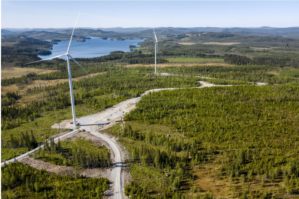
Kuva 21. Tuulivoimapuisto, huoltotie ja nostoalueet (kuvan lähde: YIT Suomi Oy).
