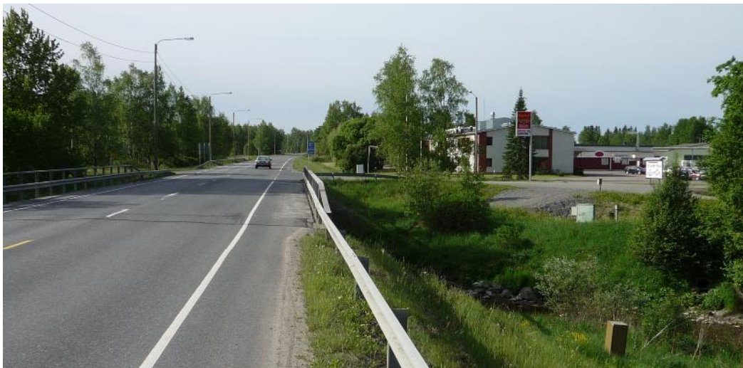
Kuva 5. Valtatie 12 etelään Takkulantien liittymän kohdalla, edessä Sammunjoen silta
