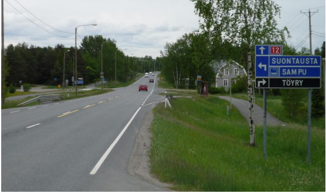
Kuva 6. Suontaustantien liittymä. Kameran kohdalla Sammun koululle johtavan Norrintien liittymä ja liittymien välissä kevyen liikenteen alikulku.
