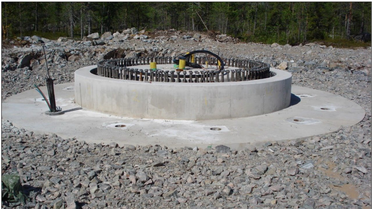
Kuva 21. YIT Suomi Oy:n toteuttama tuulivoimalan kallioankkuroitu teräsbetoniperustus (kuvan lähde: YIT Suomi Oy).
